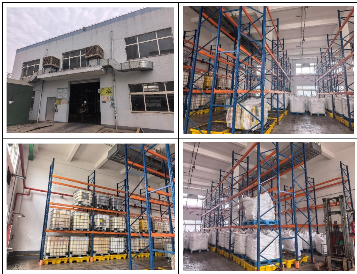
图 4.1-8 危险废物暂存库
