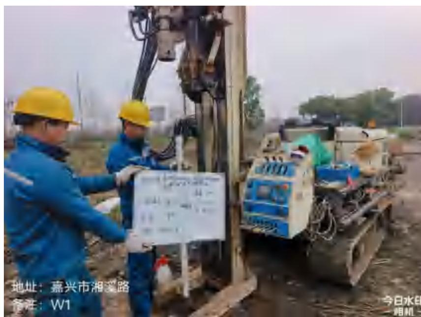
图5.2-3 地下水建井下管照片
