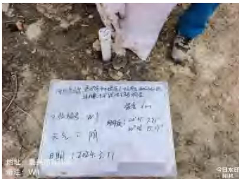
图5.2-4 滤料填充照片
